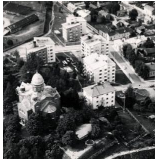
Pallon alueen ensimmäiset kerrostalot rakentuivat Liisankadun varrelle. Kuva: Albin Aaltonen, EKM.
