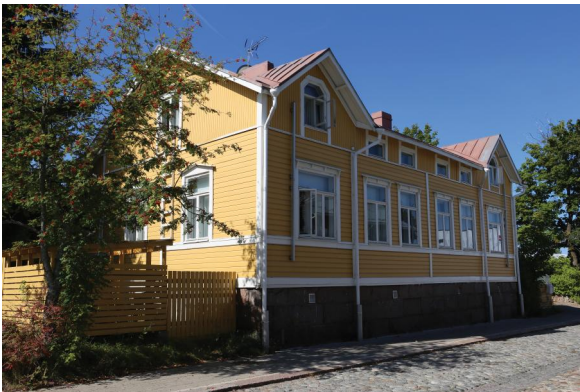
Pallonkatu 9:ssä (1907) on ullakkokerroksessa päätykolmiot, joissa kaariaiheiset ikkunat. Kuva: Tiina Heikkilä 2019, Ramboll.
