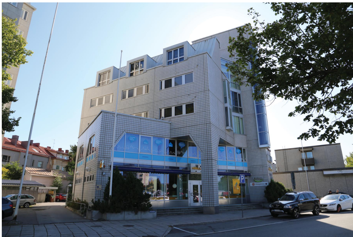
Toikankatu 4 (1987) sijaitsee torin laidalla. Suunnittelusta vastasi Arkkitehti toimisto Eino Tuompo. Kuva: Tiina Heikkilä 2019, Ramboll.
