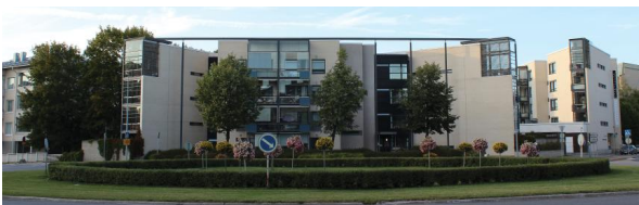
Taikinmäen palvelutalo muodostaa maisemallisen kiintopisteen Valtakadun liikenneympyrän pohjoispuolelle. Kuva: Laura Vikman 2019, Ramboll.
