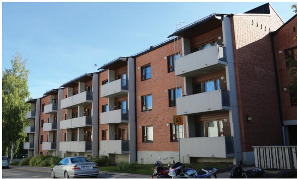
LOAS-Pallo edustaa tyypillistä 1980-luvun kerrostalorakentamista. Kuva: Tiina Heikkilä 2019, Ramboll.
