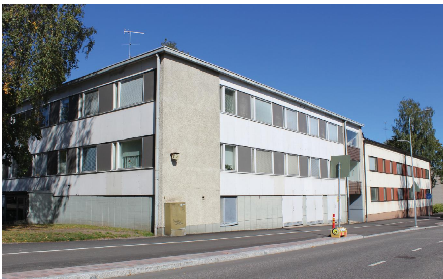
Imatrantie 2:n suunnittelusta vastasi arkkitehti Pauli Vuorinen. Kohde on osa kuuden matalan pienkerrostalon ryhmää, jotka on rakennettu vuosina 1954-1984. Kuva: Laura Vikman 2019, Ramboll.
