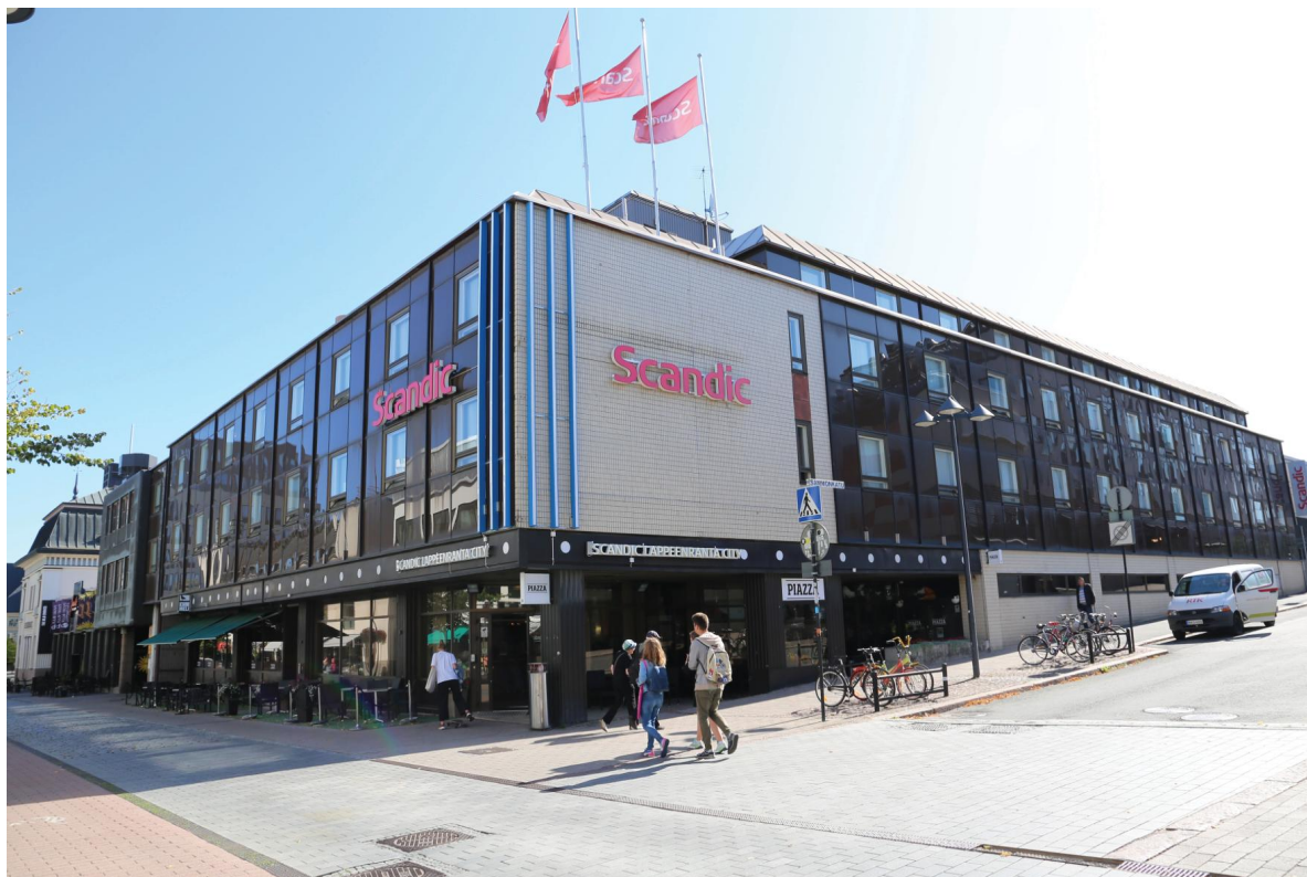
Valtakatu 31:n liikerakennus . Kuva: Tiina Heikkilä 2019, Ramboll.
