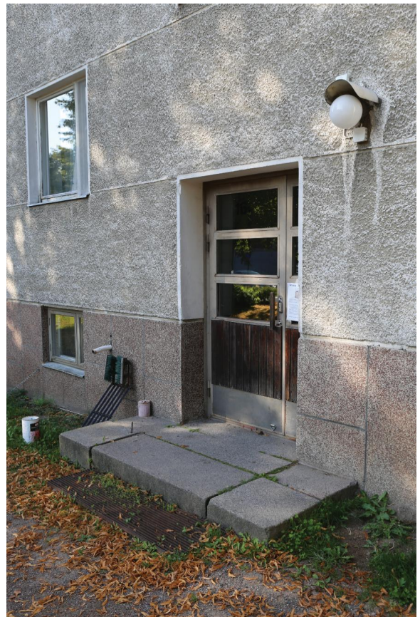
Valtakatu 16:n (1953) julkisivuissa on säilynyt runsaasti alkuperäisiä elementtejä. Kuva: Tiina Heikkilä 2019, Ramboll.
