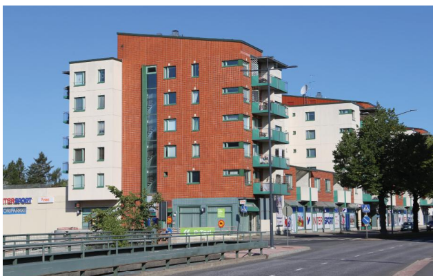
Snellmaninkatu 5 (1996) muodostuu kolmesta 6-kerroksisesta pistetalosta sekä näiden välissä olevasta 2-kerroksisesta rakennusosasta. Kuva: Tiina Heikkilä 2019, Ramboll.
