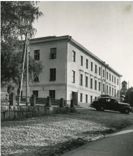
Vuonna 1931 valmistunut entinen Rikkihappotehtaan pääkonttori edustaa niin sanottua pohjoismaista klassismia. Kuva: Eino Mäkinen, LKA.
