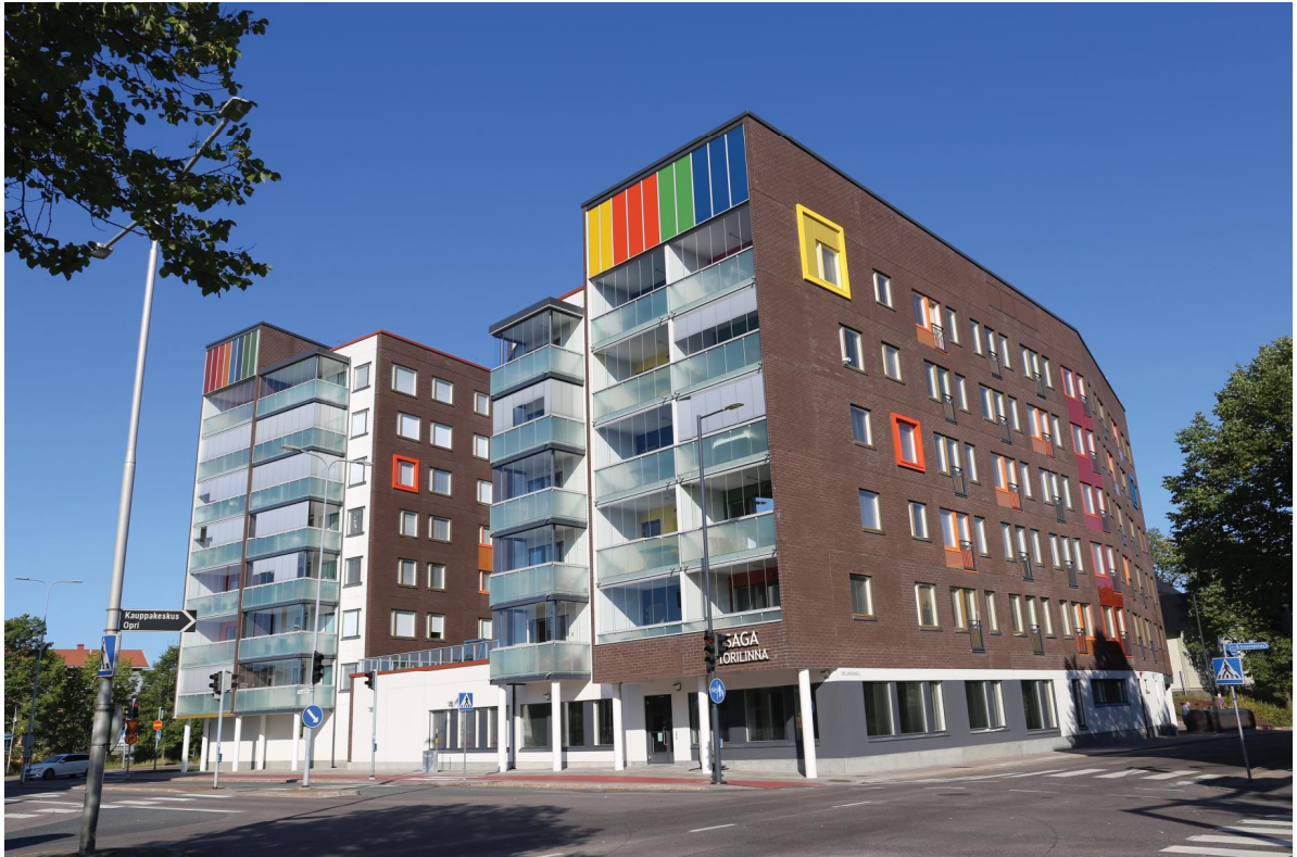
Snellmaninkatu 3 C ja 3 D:n julkisivuissa on käytetty tehosteväreinä päävärejä. Kuva: Tiina Heikkilä 2019, Ramboll.
