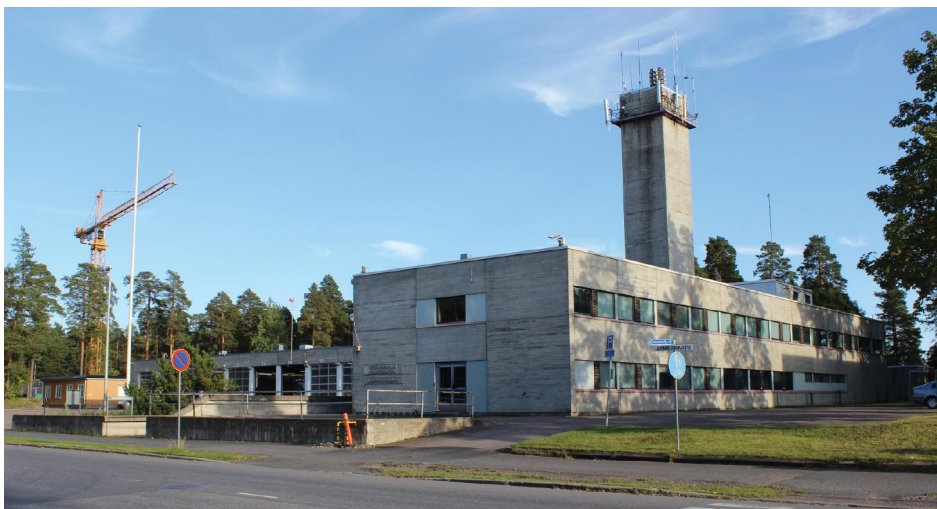
Pelastuslaitos (Armi-lankatu 35) valmistui vuonna 1977 ja se edustaa 1970-luvun elementtirakentamista, jonka piirteet ja materiaalit ovat hyvin säilyneet. Kuva: Laura Vikman 2019, Ramboll.
