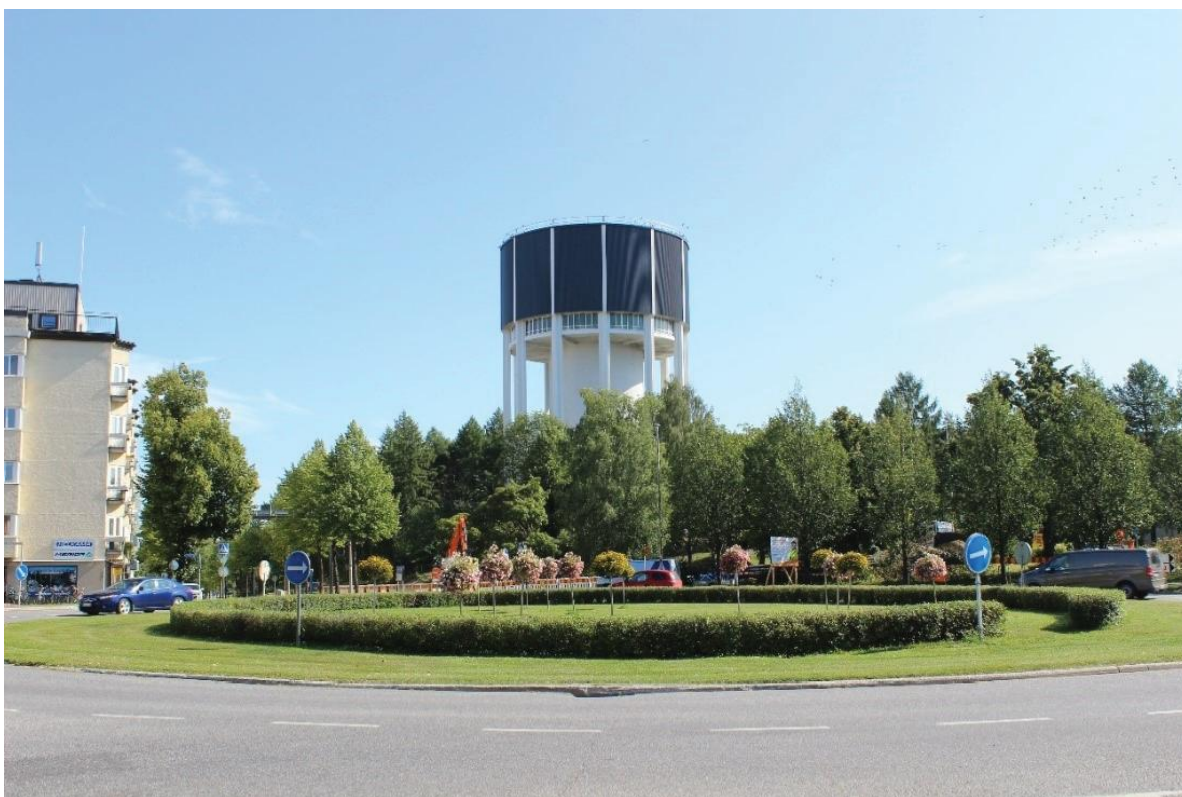
Lappeenrannan vesitorni muodostaa maisemallisen kiintopisteen Taikinmäen liikenneympyrän tuntumaan. Vesitornia uudistettiin matkailukäyttöä varten 1950-luvulla, jolloin myös liikenneympyrä rakennettiin Valtakadulle. Kuva: Laura Vikman 2019, Ramboll.
